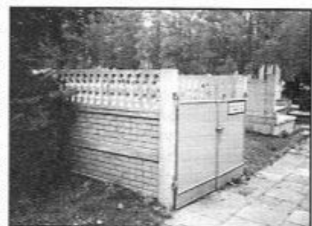
Przy głównych alejach śmietniki w formie altan.
