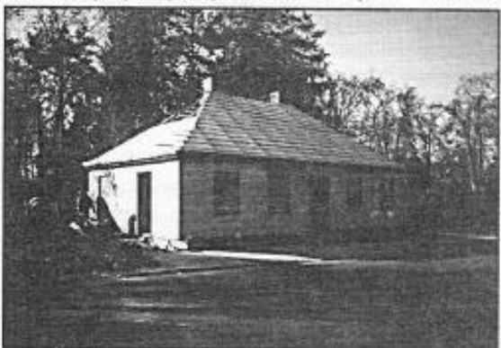
W remontowanym domu grabarza powstanie nowoczesne funerarium.
